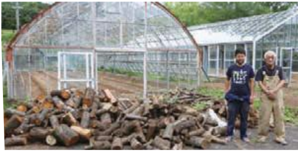
東彼杵町の協力で設置した薪の乾燥施設
