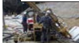
アンカー工事-厳原町久根
