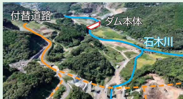
建設予定地の状況(令和6年9月26日現在)
