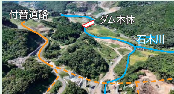
建設予定地の状況(令和6年9月26日現在)
